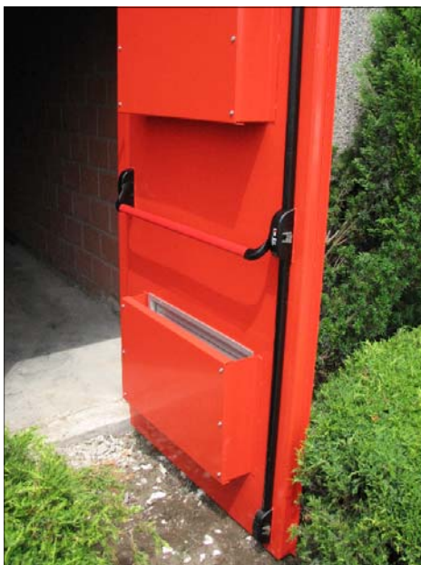
Details 3-punt panieksluiting , roosters met doorsteekbeveiliging
