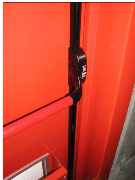
Details 3-punt panieksluiting , roosters met doorsteekbeveiliging
